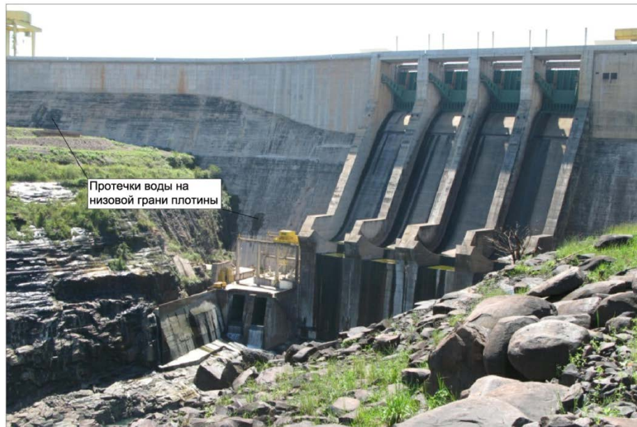
Рисунок 6.2.1 - Плотина из укатанного бетона
