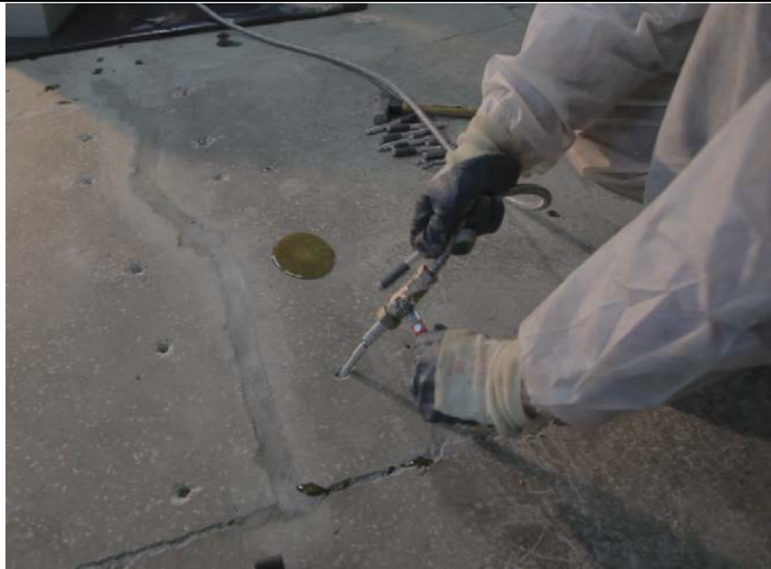
Рисунок 7.2.31 - Выполнение инъекционных работ
