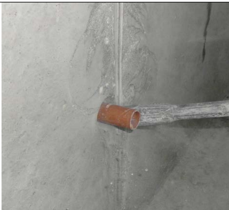
Рисунок 7.2.53 - Удаление пластиковой втулки
