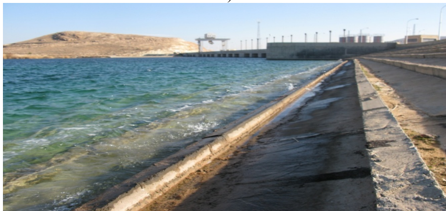
Рисунок 6.6 - Железобетонные крепления откосов грунтовых плотин:
