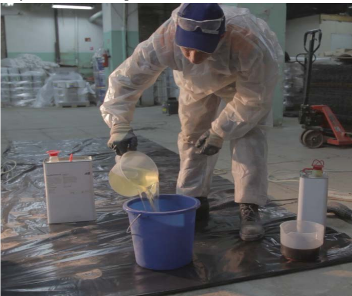
Рисунок 7.2.30 – Дозирование компонентов смолы
