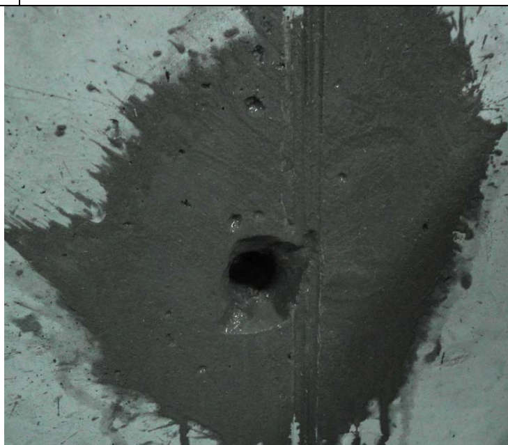
Рисунок 7.2.54 - Увлажнение отверстия
