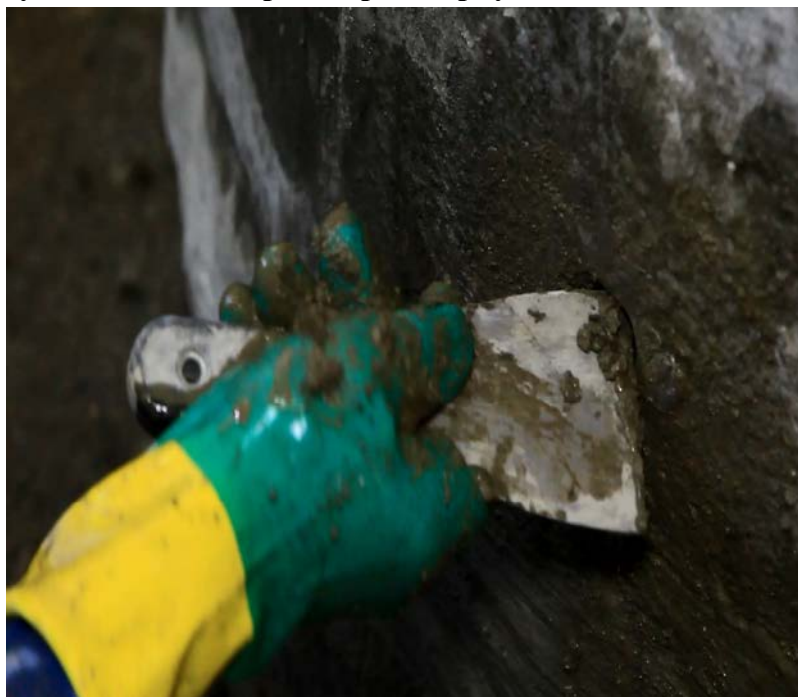
Рисунок 7.2.39 – Удалить остатки растворной смеси из полости течи
