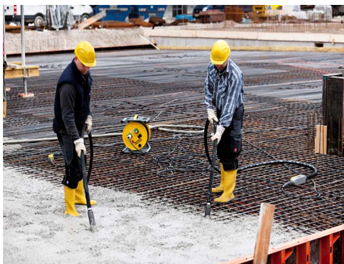
Рисунок 7.1.3 - Укладка бетонной смеси
