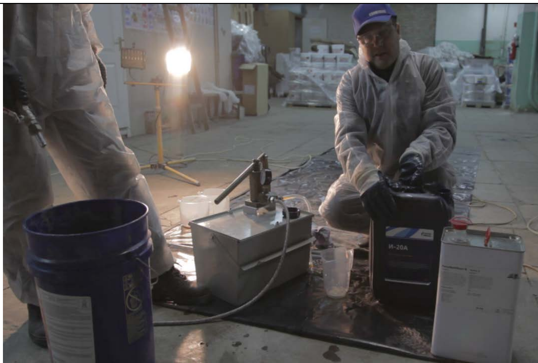
Рисунок 7.2.28 - Промывка гидравлическим маслом
