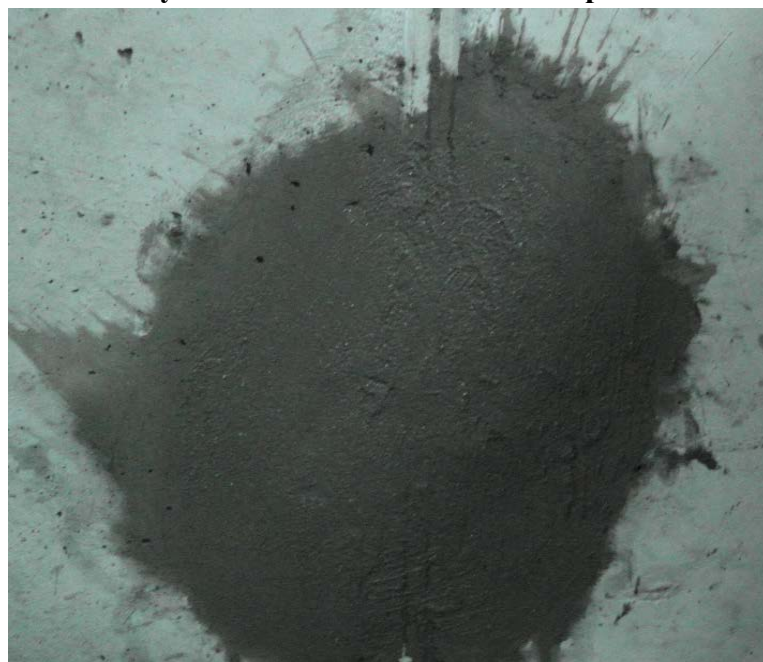
Рисунок 7.2.56 - Общий вид отверстия после выполнения гидроизоляционных работ
