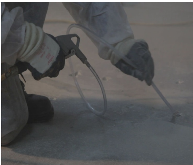
Рисунок 7.2.23 – Очистка отверстий сжатым воздухом от остатков бурения
