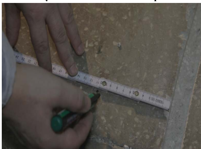
Рисунок 7.2.21 – Выполнение разметки для установки инъекторов
