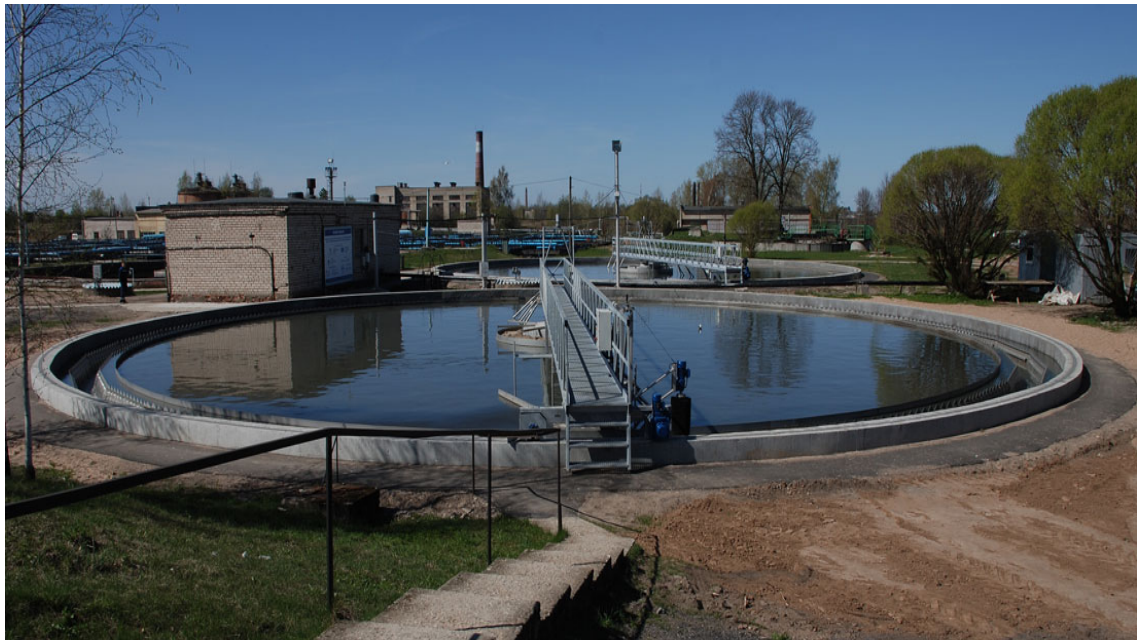
Рисунок 6.4.1 - Радиальный отстойник из монолитного железобетона: а - опорожненный; б – в период эксплуатации
