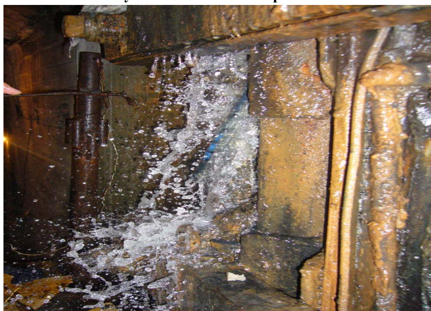
Рисунок 7.2.34 - Напорная течь
