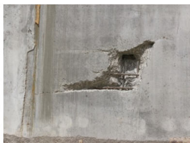
Рисунок 6.8 - Напорные водоводы гидроаккумулирующей станции: а – панорама строительства водоводов; б – дефектные участки бетона на поверхности водовода
