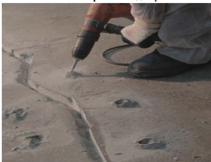
Рисунок 7.2.22 – Бурение отверстий для установки инъекторов
