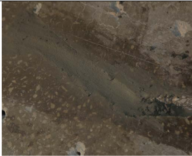
Рисунок 7.2.26 – Штраба, заполненная раствором смеси «Скрепа М500 Ремонтная»
