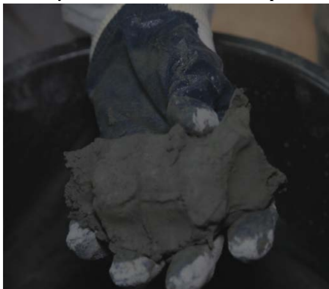
Рисунок 7.2.25 – Приготовление растворной смеси «Скрепа М500 Ремонтная»
